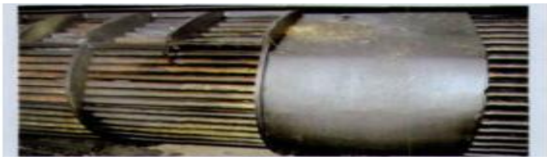
图 3 清洗后换热器管束的照片
